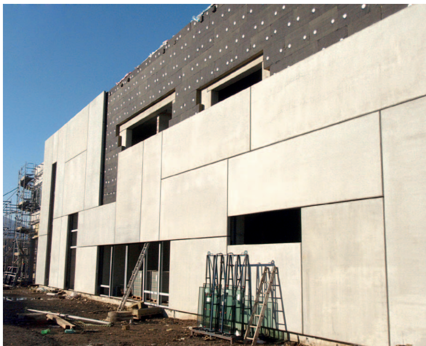
Pohled na zavěšenou fasádu
