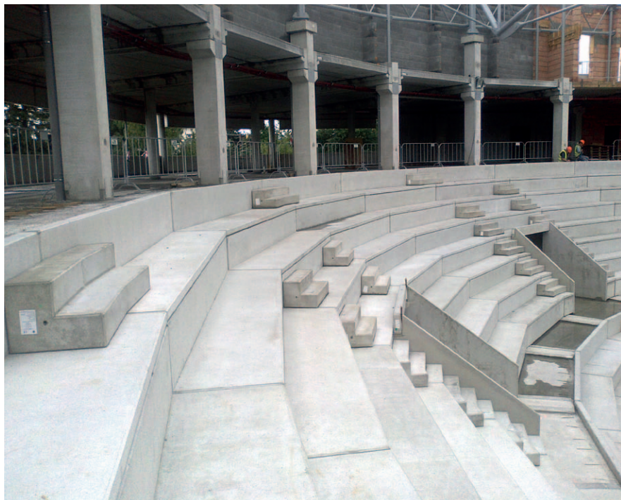
Prefabrikovaná konstrukce hlediště
