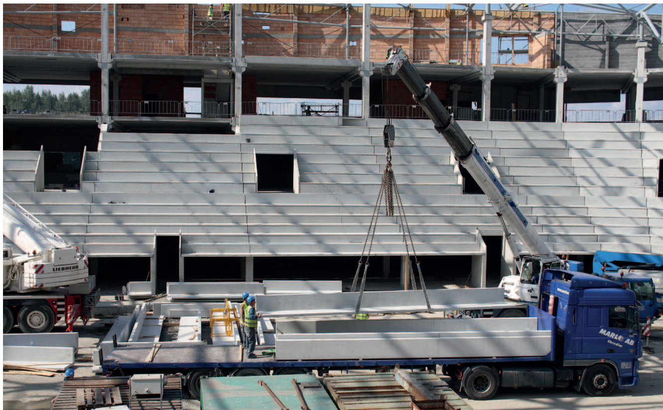
Většina dílců byla navržena v délce do 12 m a max. hmotnosti 24 tun, což umožnilo přepravu na běžných dopravních prostředcích.
